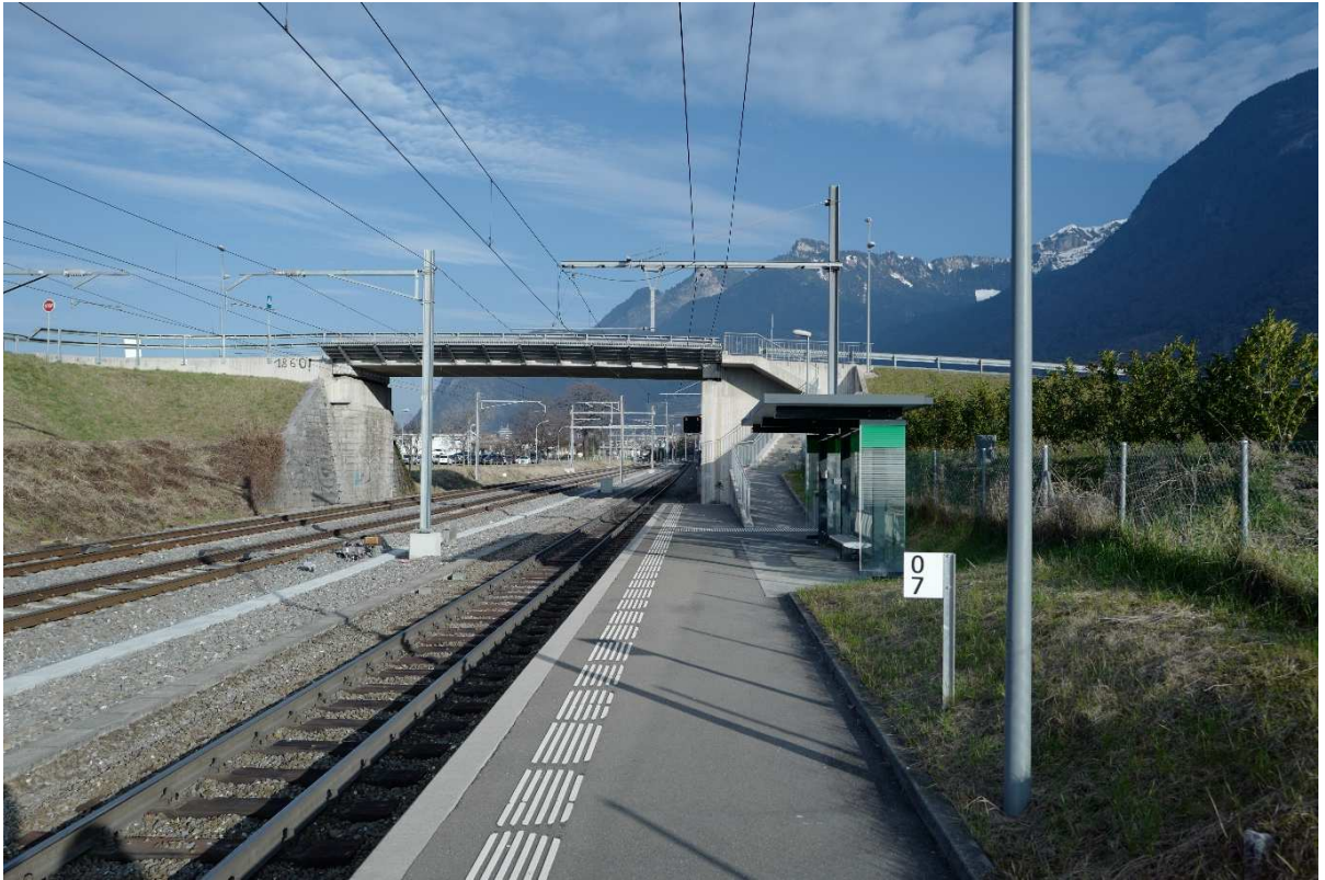
Image 01 - Vue de l'arrêt Hôpital (ligne AOMC) en direction Aigle.
